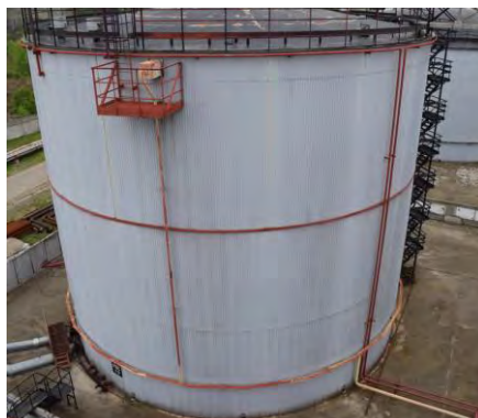
Рисунок 1 – Общий вид резервуаров
